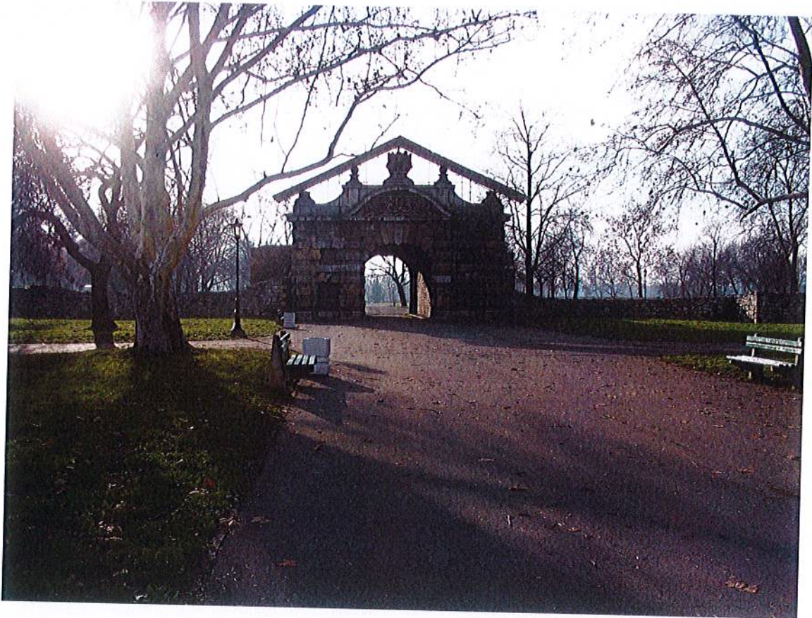
Поглед на североисточну фасаду и простор некадашњег присупног моста и водене површина
