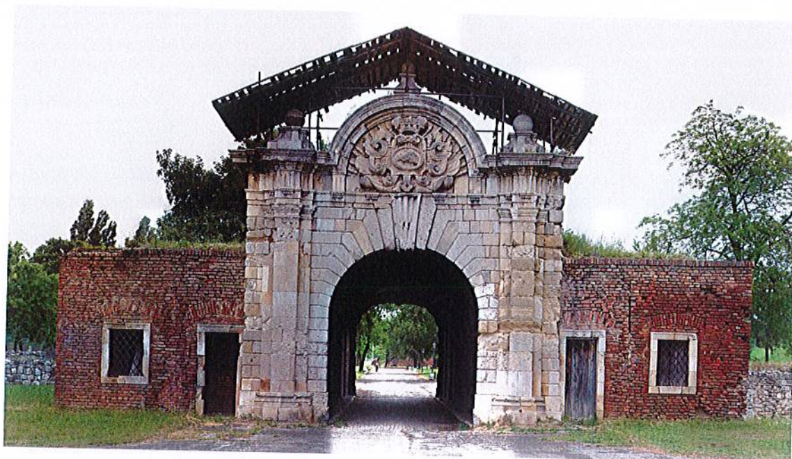
Поглед на југозападну фасаду капије (фотографија израђена у Централном институту за конзервацију)
